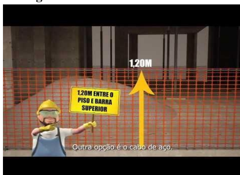
Figura 16 - Sistema de Barreira com Rede
