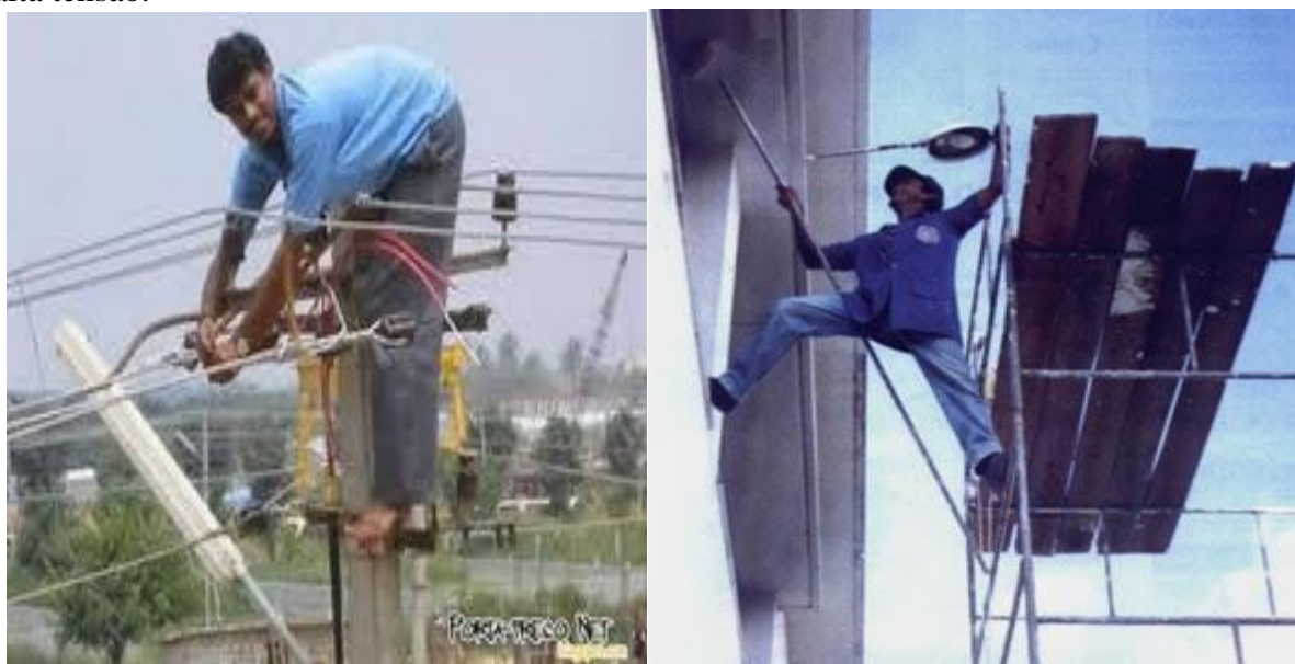
Figura 1e 2: Ato inseguro: Sem utilizar EPI's na execução de atividades envolvendo altura e alta tensão.
