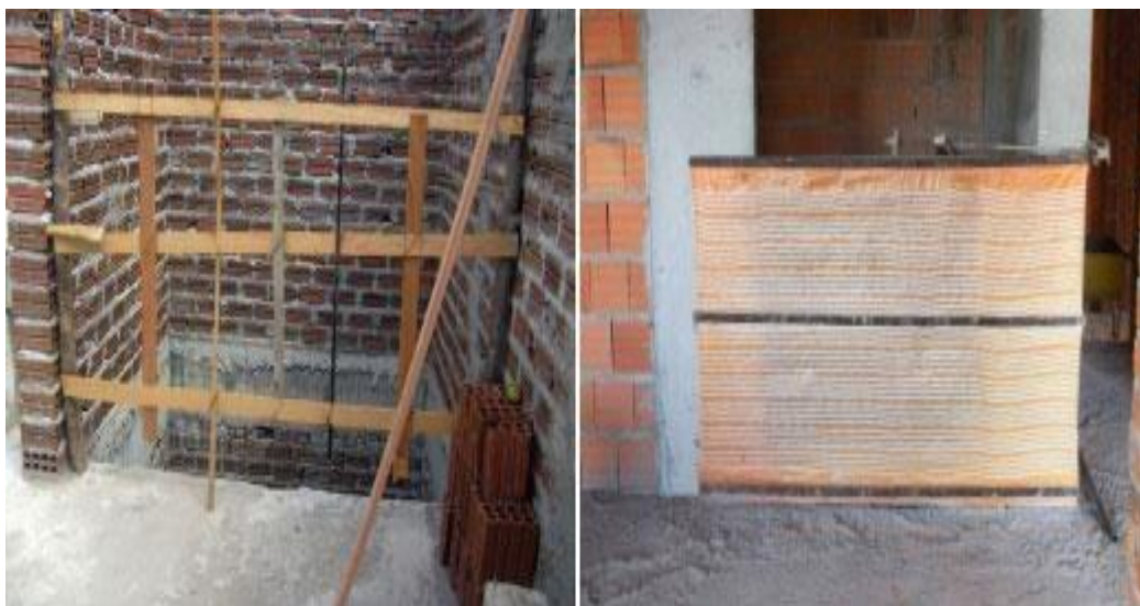
Figura 14. Instalação de proteção
