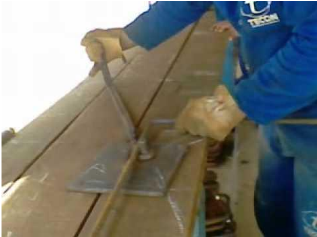
Figura 10: Armador na dobragem de ferro
