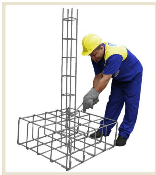
Figura 7: Armações de ferro
