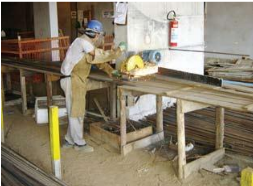
Figura 9: Operador de policorte
