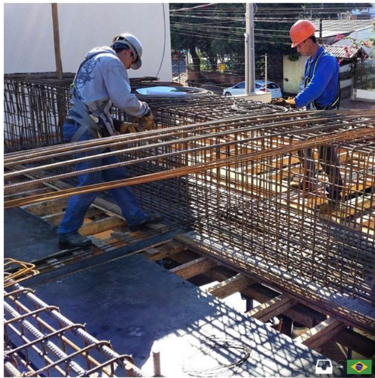
Figura 11: Armações de ferragens
