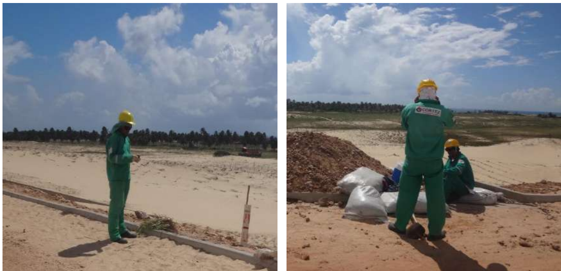
Figura 7: Funcionários fazendo uso de Equipamentos de Proteção Individual (EPI)
