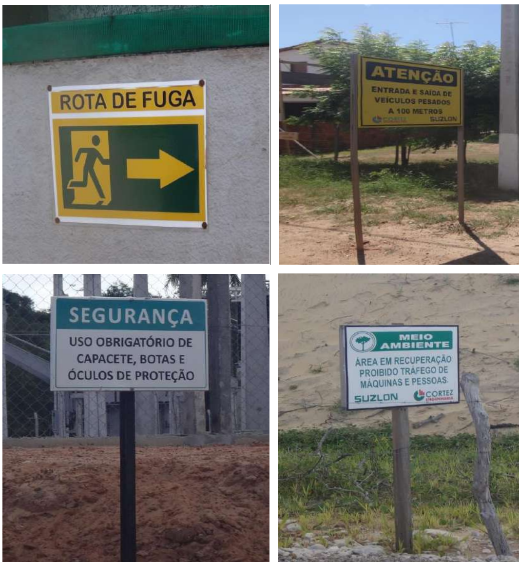
Figura 14: Exemplos de sinalização de segurança utilizados na construção da usina eólica Andorinha
