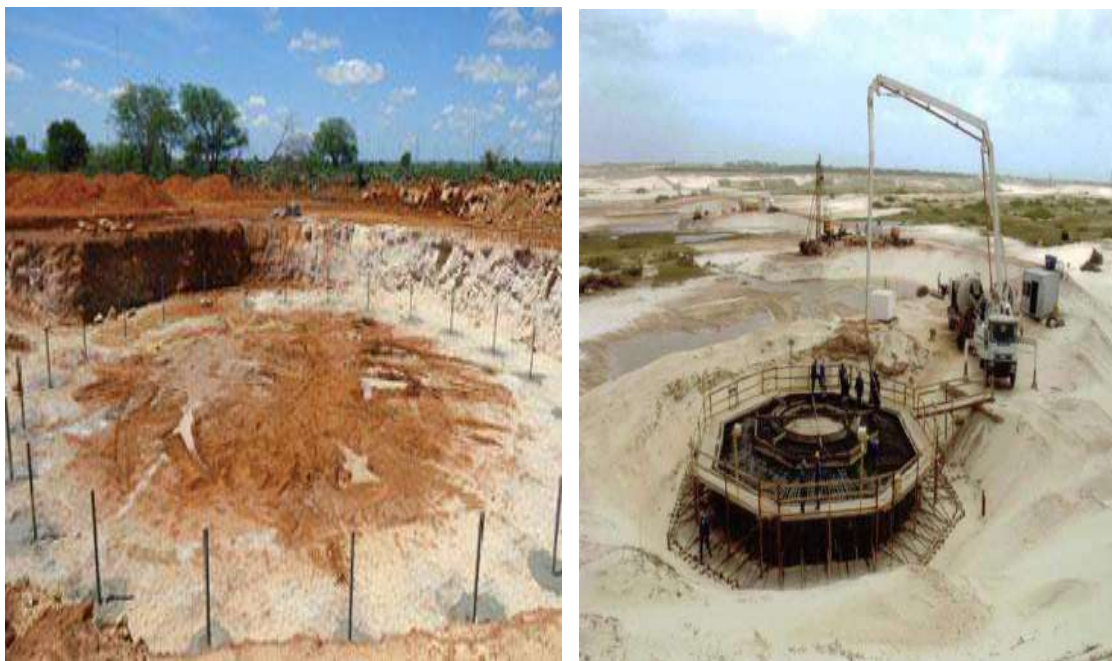
Figura 10: Estruturação e fundação de bases das torres dos aerogeradores
