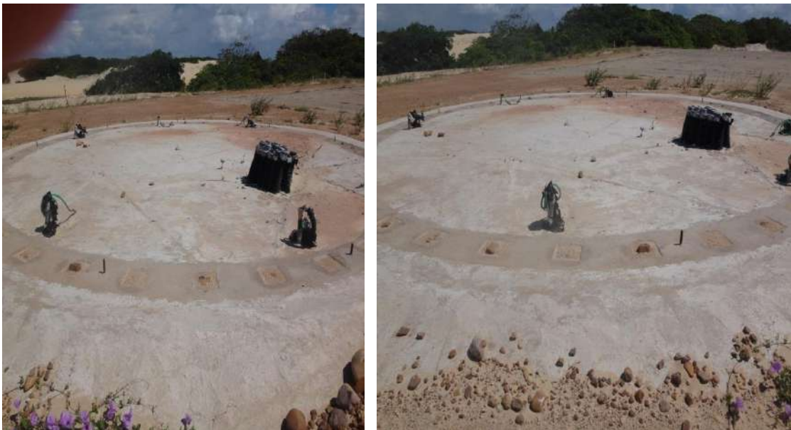
Figura 11: Processo final da construção das bases dos aerogeradores da Usina Andorinha
