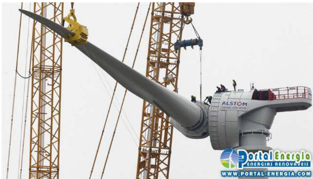
Figura 9: Trabalho realizado em altura, durante montagem de aerogeradores
