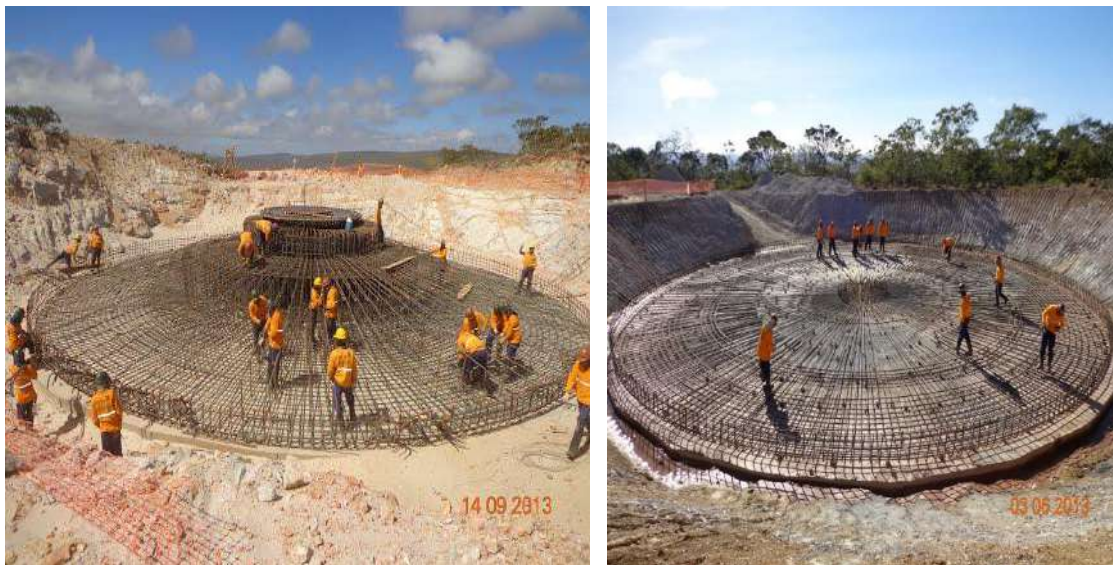
Figura 12: Processo final da construção das bases dos aerogeradores da Usina Andorinha
