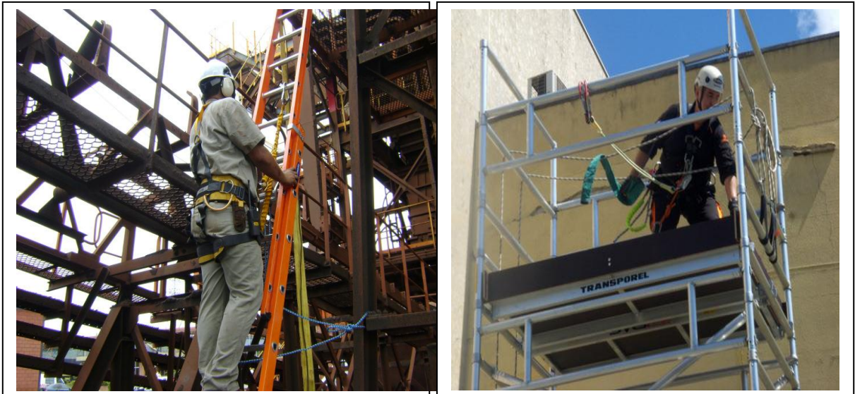
Figura 1. Escadas Móveis – Andaime de Torre
