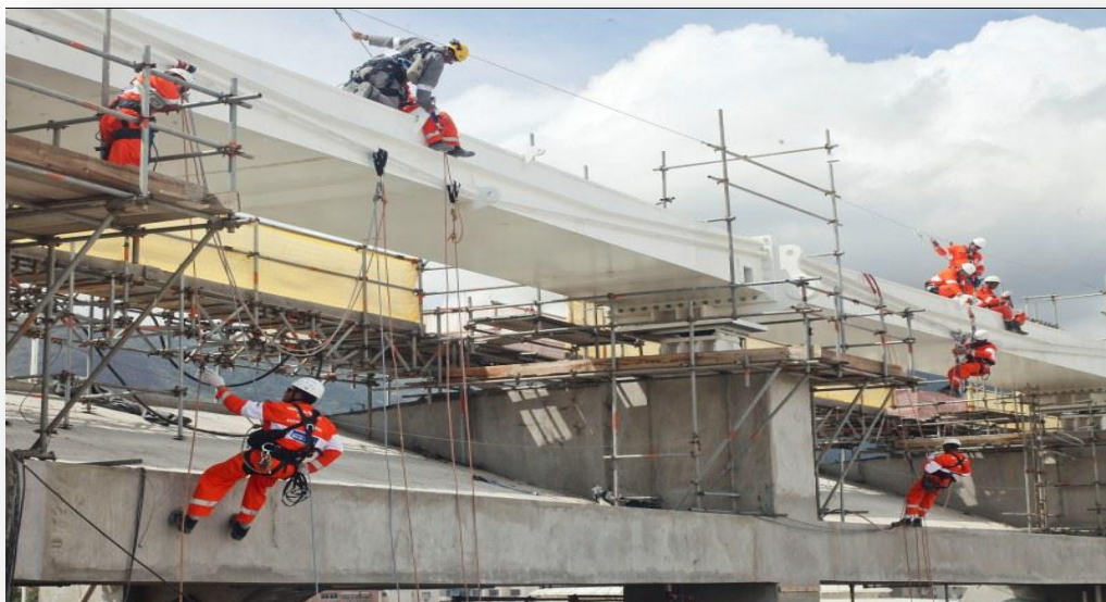
Figura 10: Trabalho em conformidade com trabalho em altura
