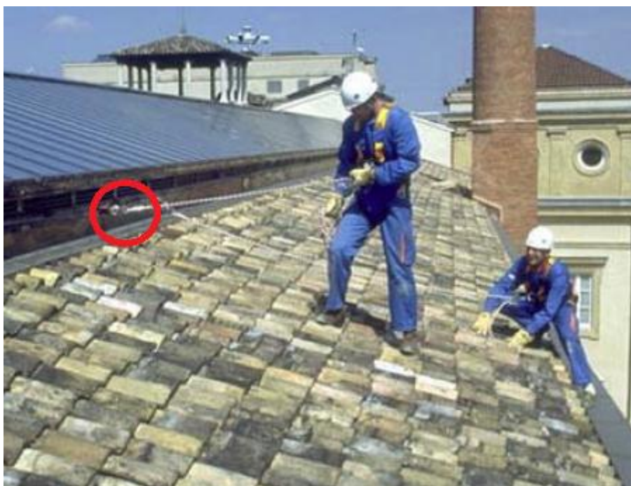
Figura 20: Fixação de Cabo-guia
