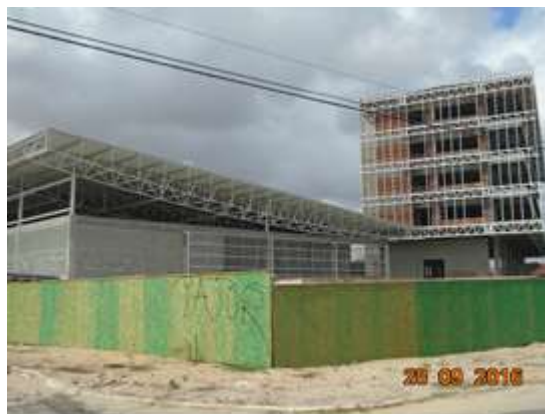
Figura 2. Bloco administrativo (depósito)
