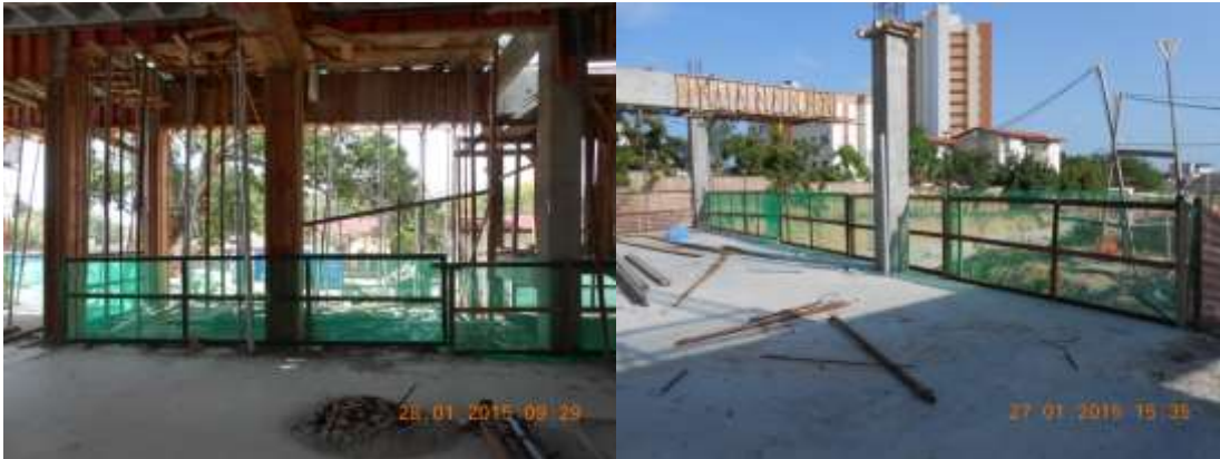
Figura 11. Guarda-corpos (EPCs) no perímetro do edifício
