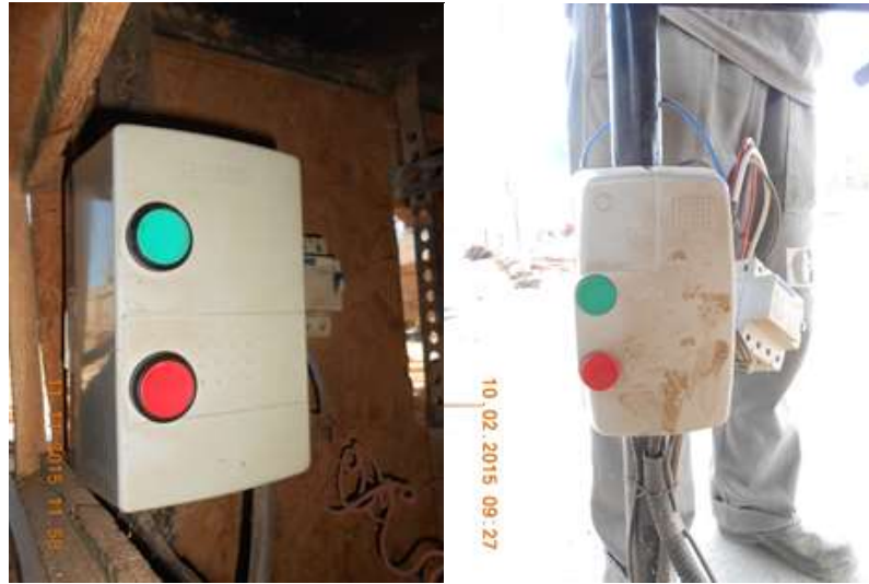
Figura 9. Conformidades (Botoneiras) no setor de carpintaria
