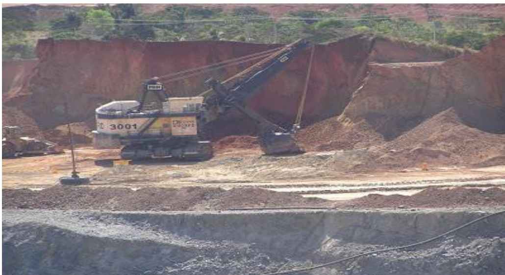
Figura 1. Remoção da camada de solo
