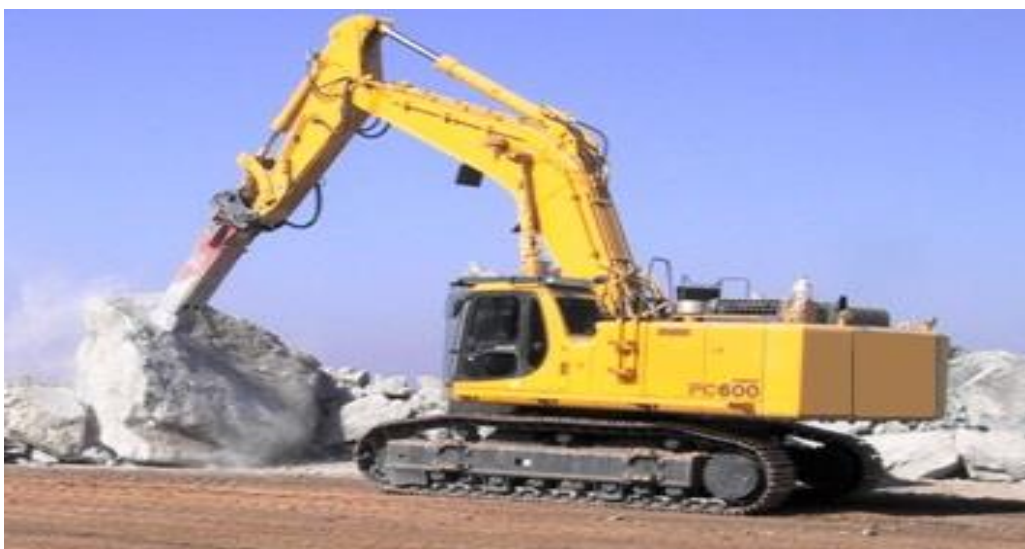
Figura 3. Reduzindo o tamanho dos blocos de rocha
