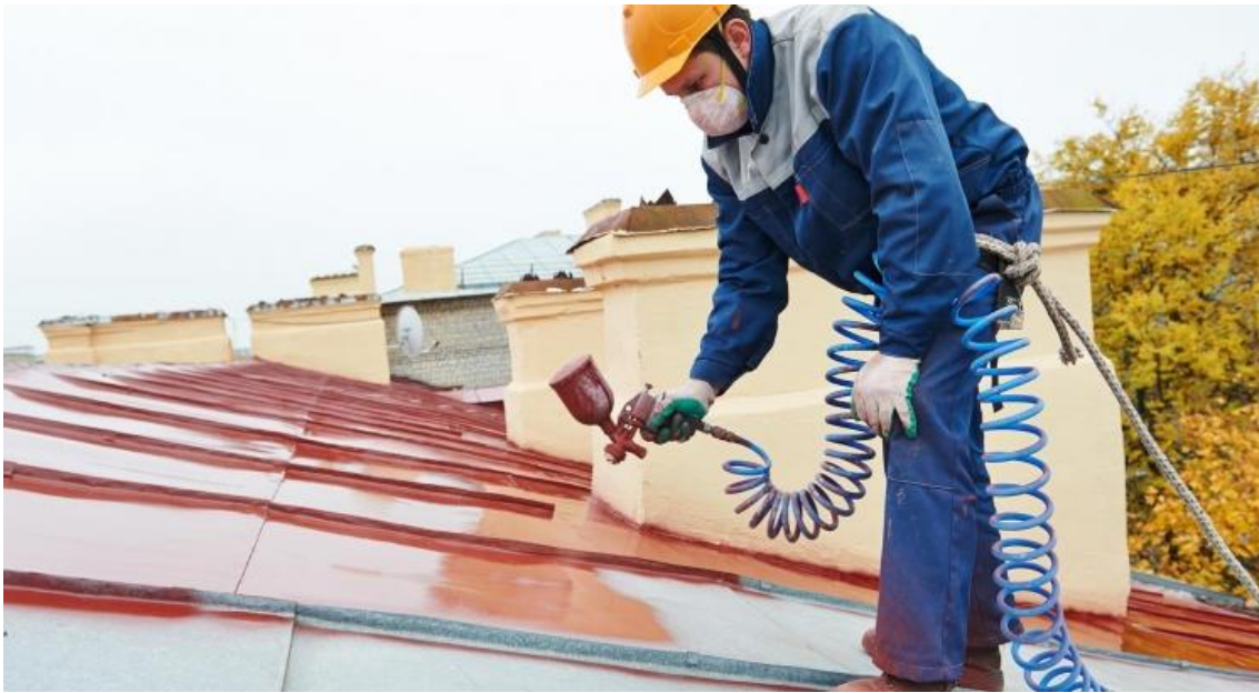
Figura 14: Trabalhador aplicando tinta térmica
