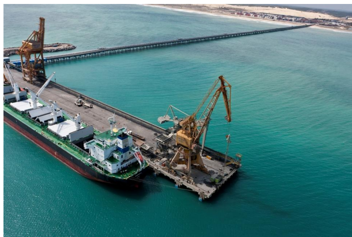
Figura 4 - Acesso marítimo ao CIPP
