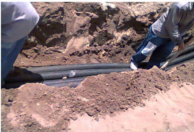
Figura 05. Canalização de dutos para passagem de cabos.
