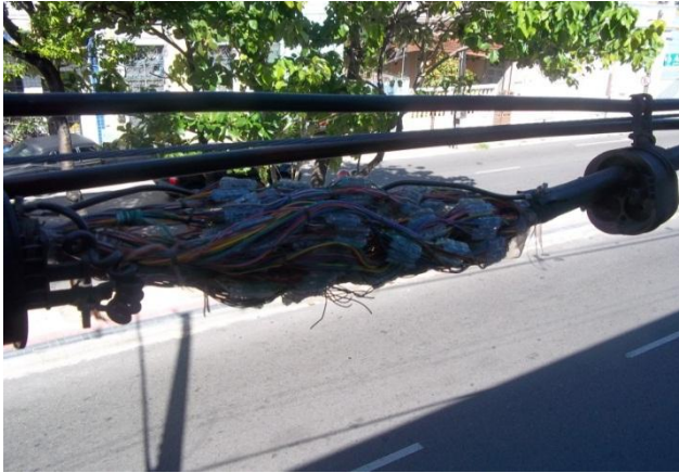
Figura 04. Emenda de cabo metálico aéreo.
