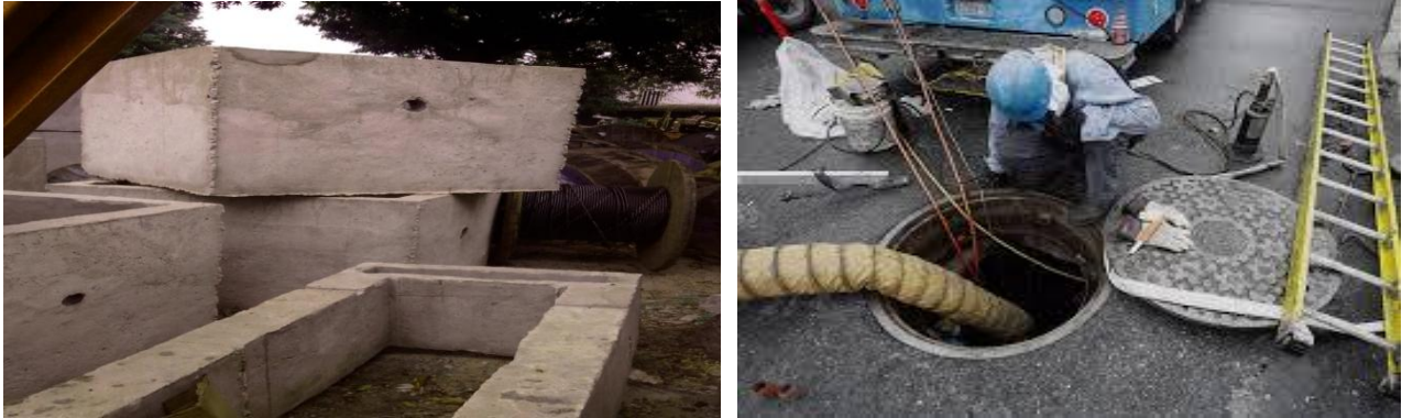
Figura 06. Construção de caixas subterrânea de concreto. Fonte: Arquivo Master
