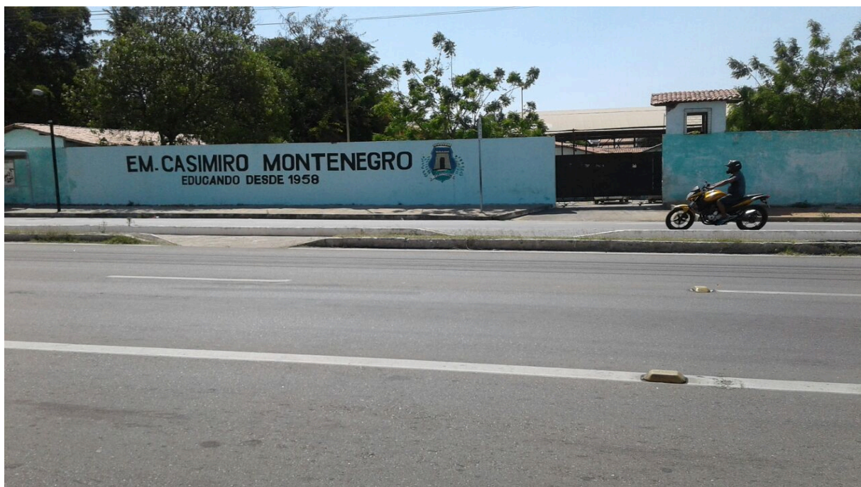
Figura 1- Fachada da Escola Municipal Casimiro Montenegro.
