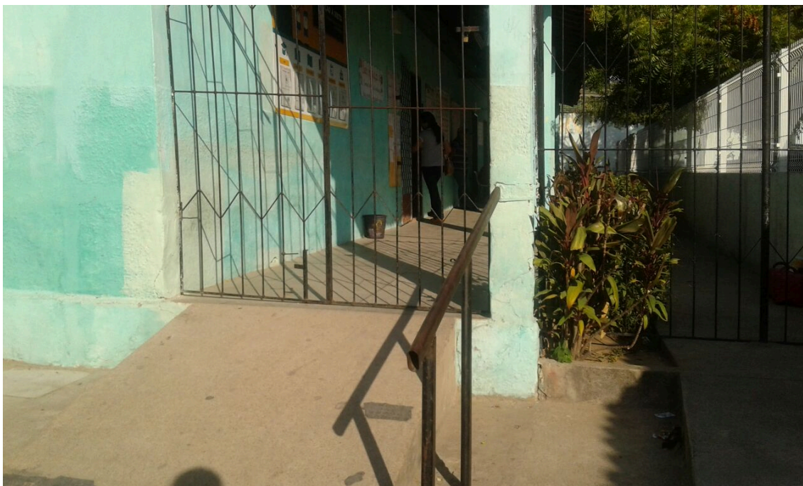
Figura 3 – Piso desregular e rampa de acesso.
