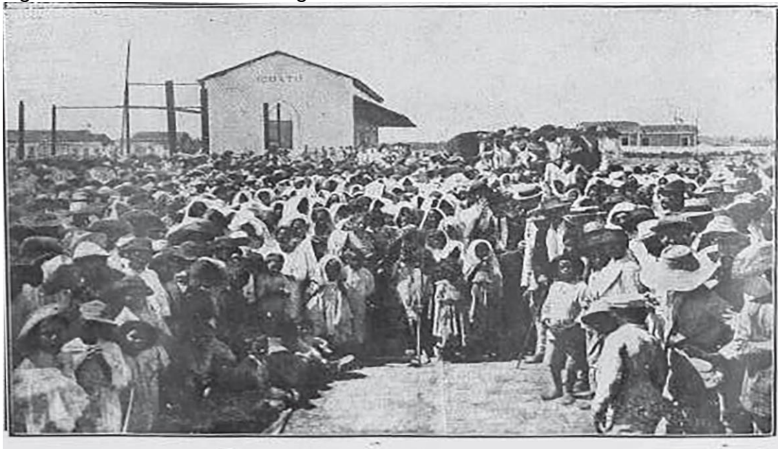
Figura 1- Estrada de ferro de Iguatu.
