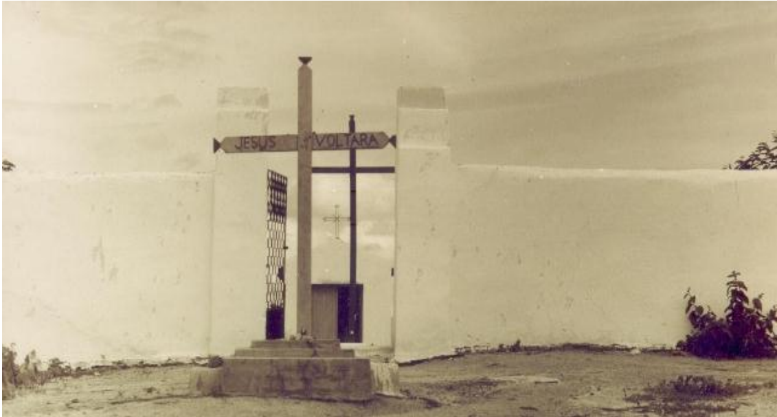
Figura 3 - Cemitério da barragem Patu
