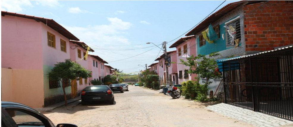
Figura 1. Rua principal do Conjunto Residencial Planalto Universo
