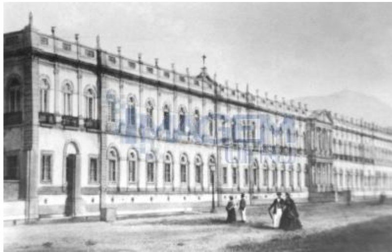
Figura 5: Fachada do Hospício Pedro II (Palácio Universitário da UFRJ) na Praia Vermelha
