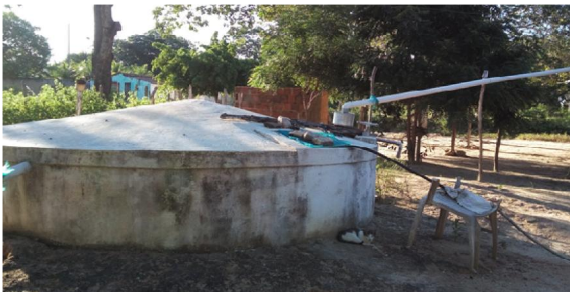
Figura 1 – Cisterna construída no município de Chorozinho
