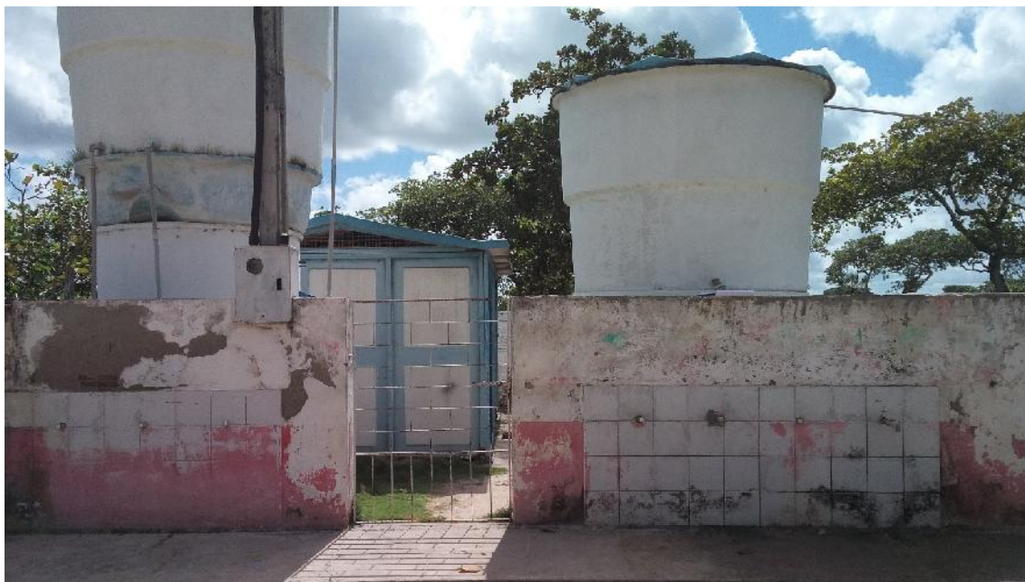
Figura 2 – Cisterna que abastece o Distrito de Campestre
